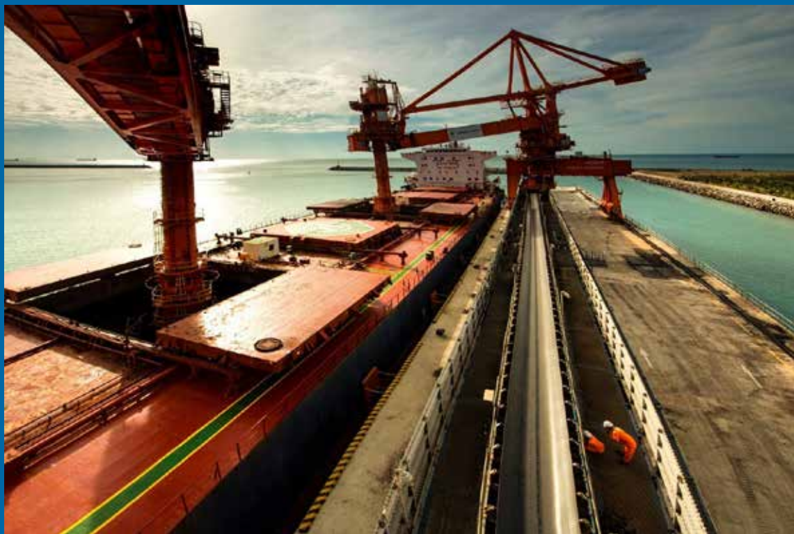
Cảng bốc dỡ than của Nhà máy Nhiệt điện Vĩnh Tân 4
