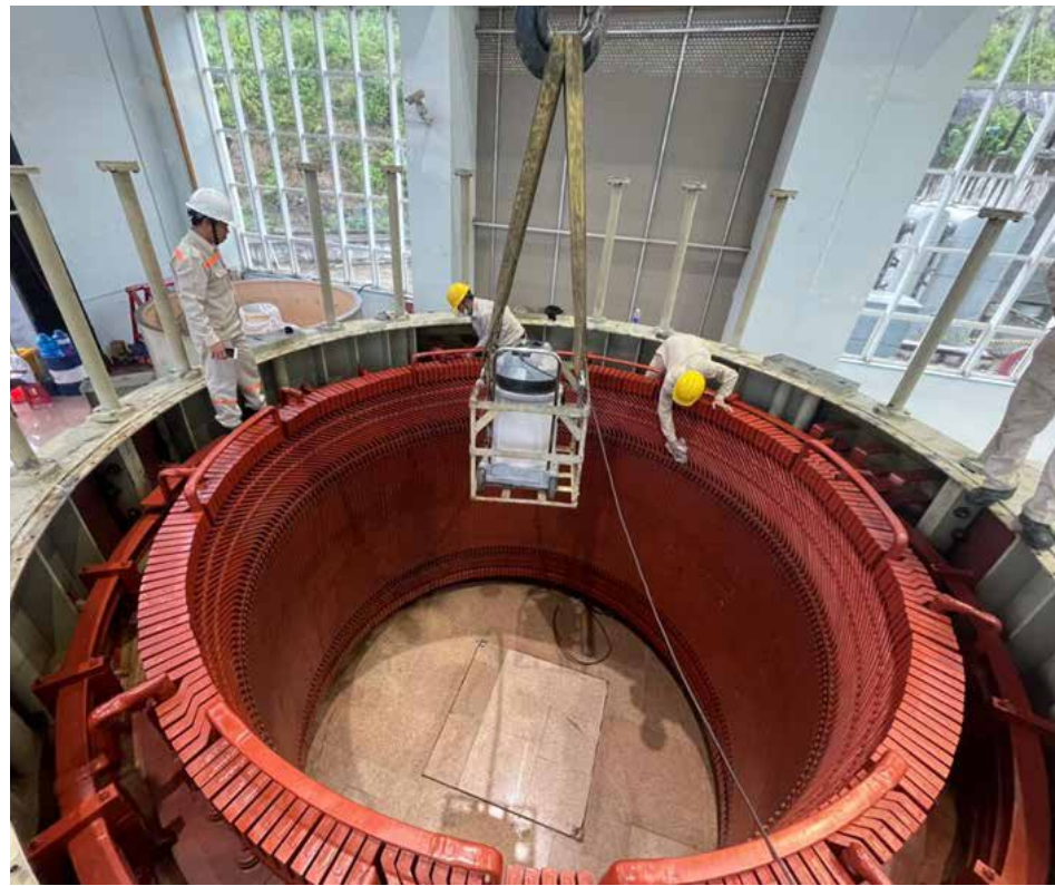
Stator máy phát nhà máy điện sau khi bảo dưỡng phòng ngừa gia tăng cách điện
