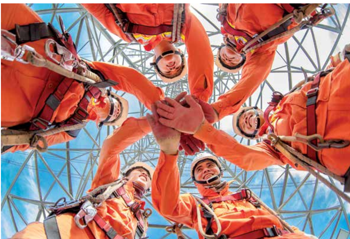
Đoàn kết thi công đường dây 500kV mạch 3 cung đoạn Quảng Trạch - Quỳnh Lưu
