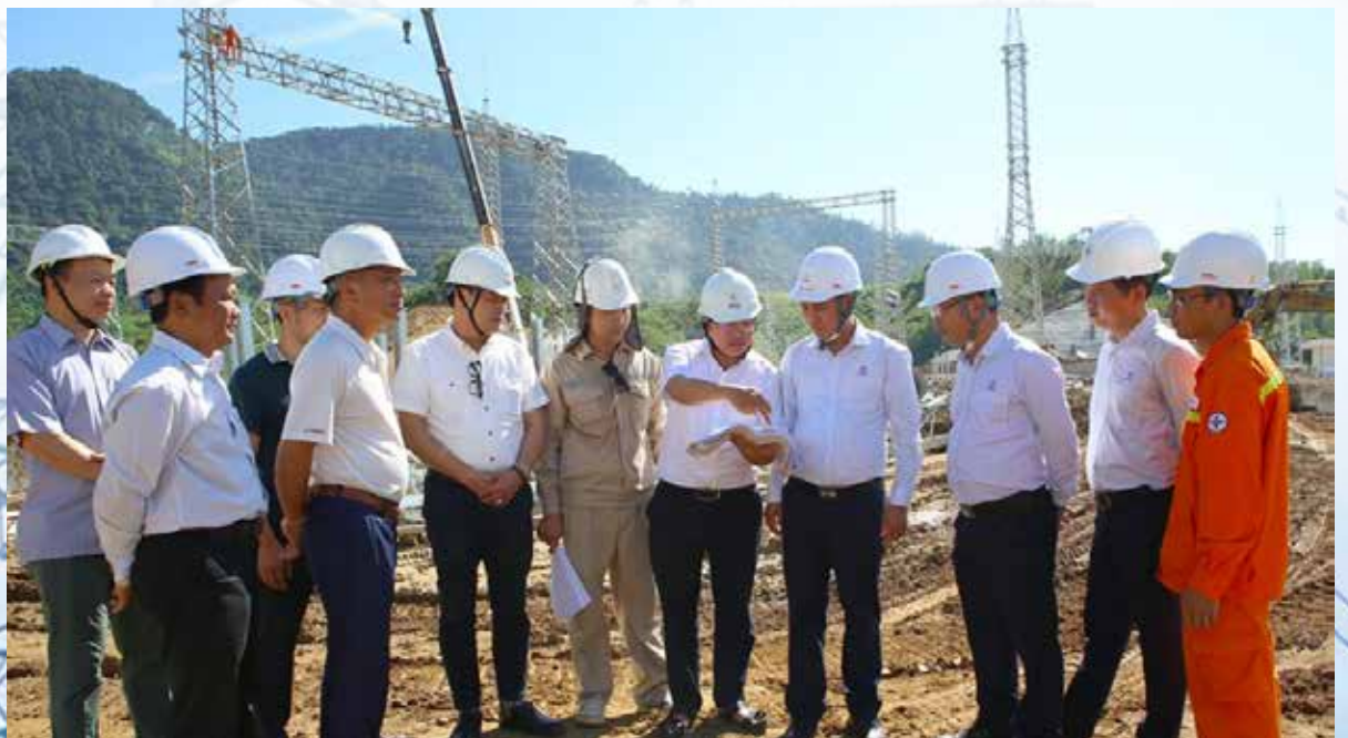
Dự án mở rộng ngăn lộ và cải tạo Trạm biến áp 500kV Thạnh Mỹ
