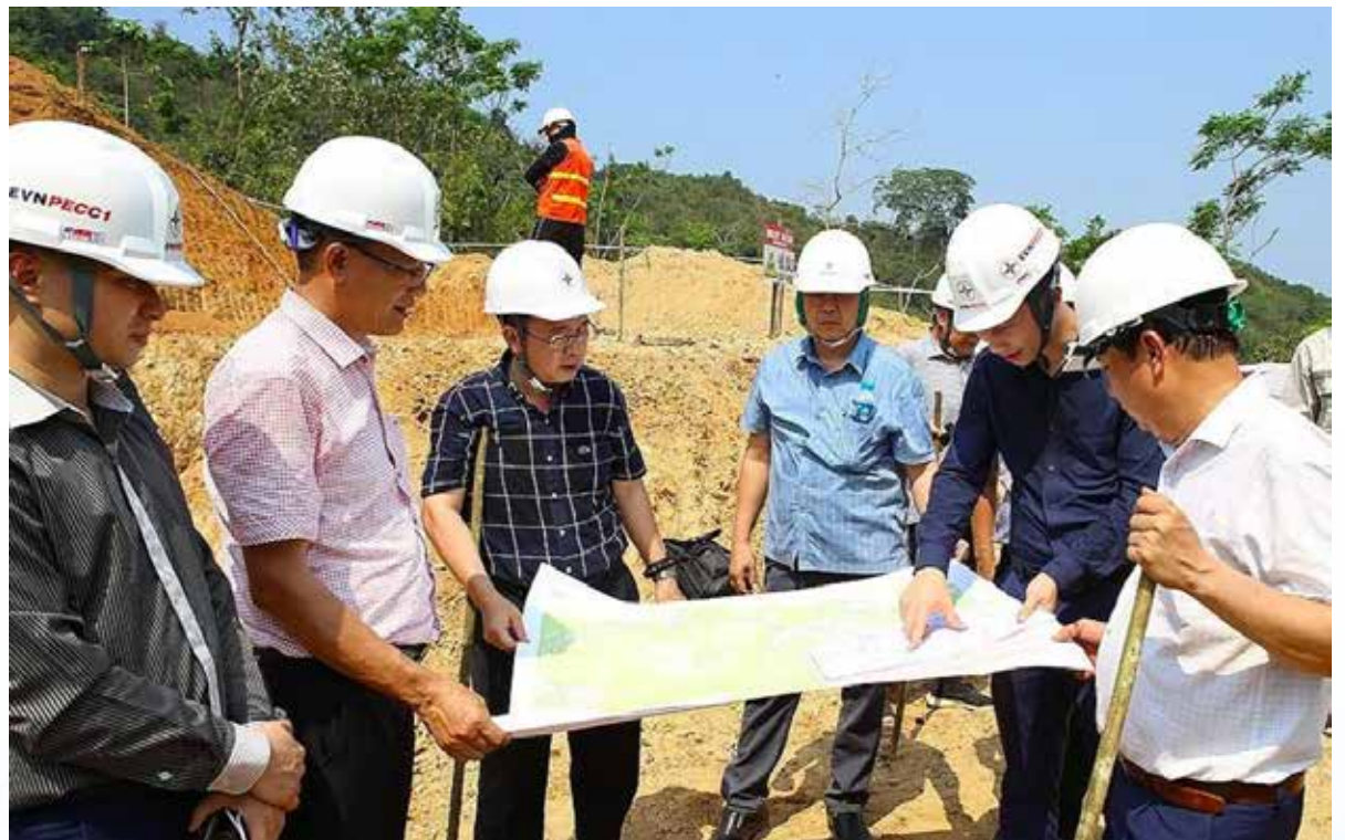
Lãnh đạo EVNNPT kiểm tra hiện trường thời điểm thi công đường dây 220kV Nậm Sum - Nông Cống
