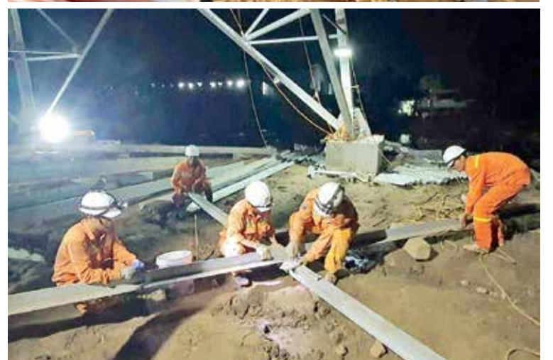
Thi công không quản ngày, đêm trên đường dây 500kW mạch 3 từ Quảng Trạch đến Phố Nối Ảnh: Anh Hiếu
