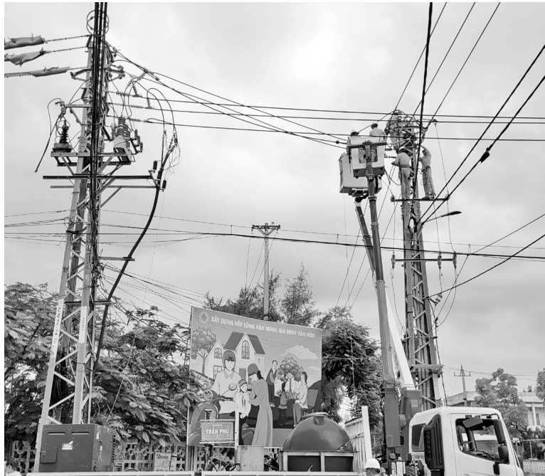
Cải tạo lưới điện hạ áp tại huyện Tuy An
