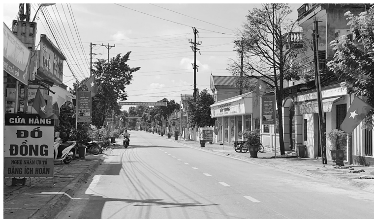
Đường giao thông nông thôn tại xã Thiệu Trung, huyện Thiệu Hóa, tỉnh Thanh Hóa
